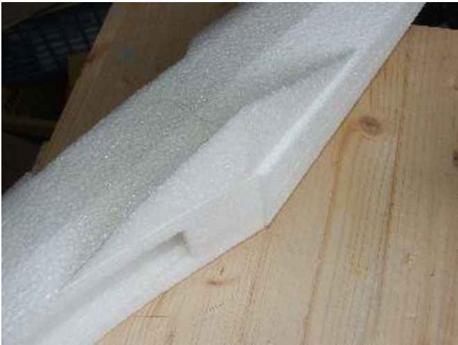
Přilepit zadní část přechodu.
