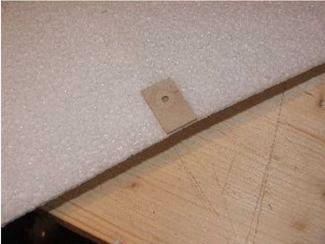
Přilepit překližkovou podložku pro šroub.
